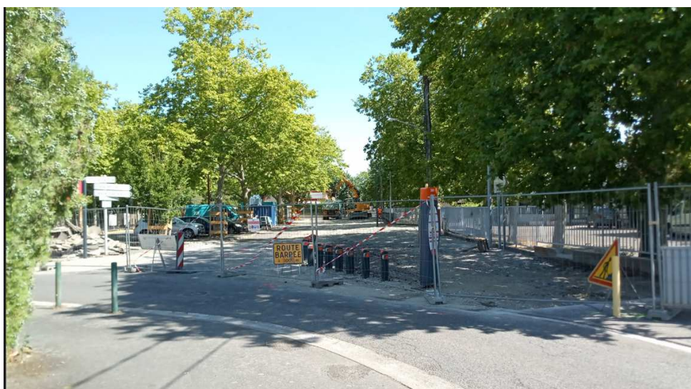
Vue de chantier le 15 juillet
