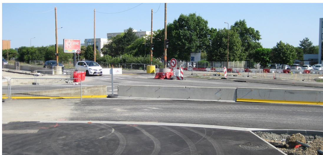
vue du chantier le 05/07/22
