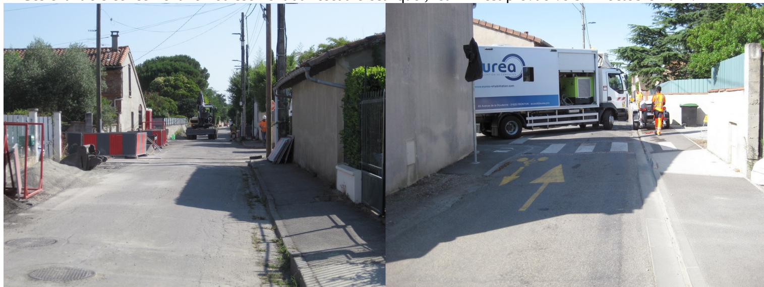
vue des chantiers sur Canto-Laouzetto le 05/07/22
