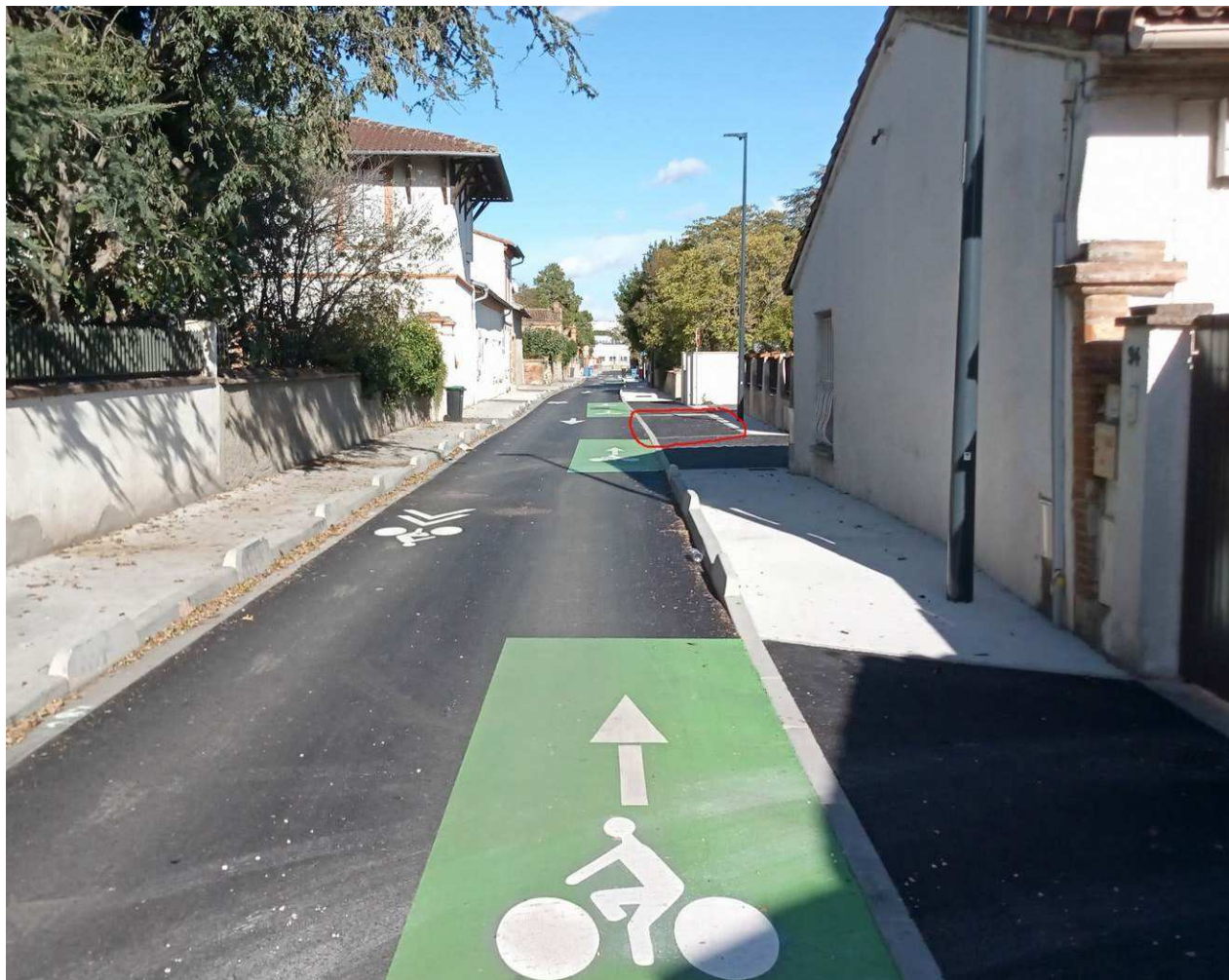
Vu du chemin (la zone cerclée rouge indique les 2 places de stationnement)
