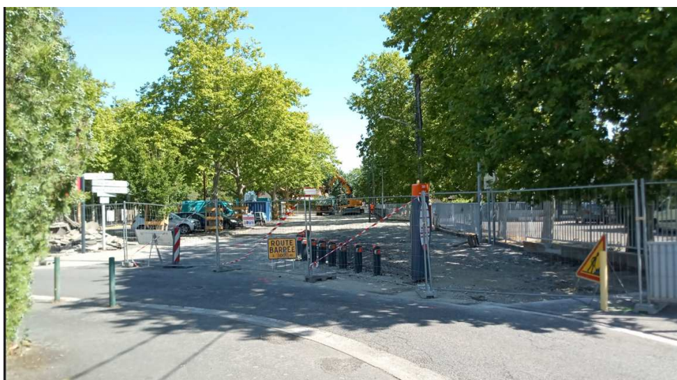
Vue de chantier le 15 juillet
